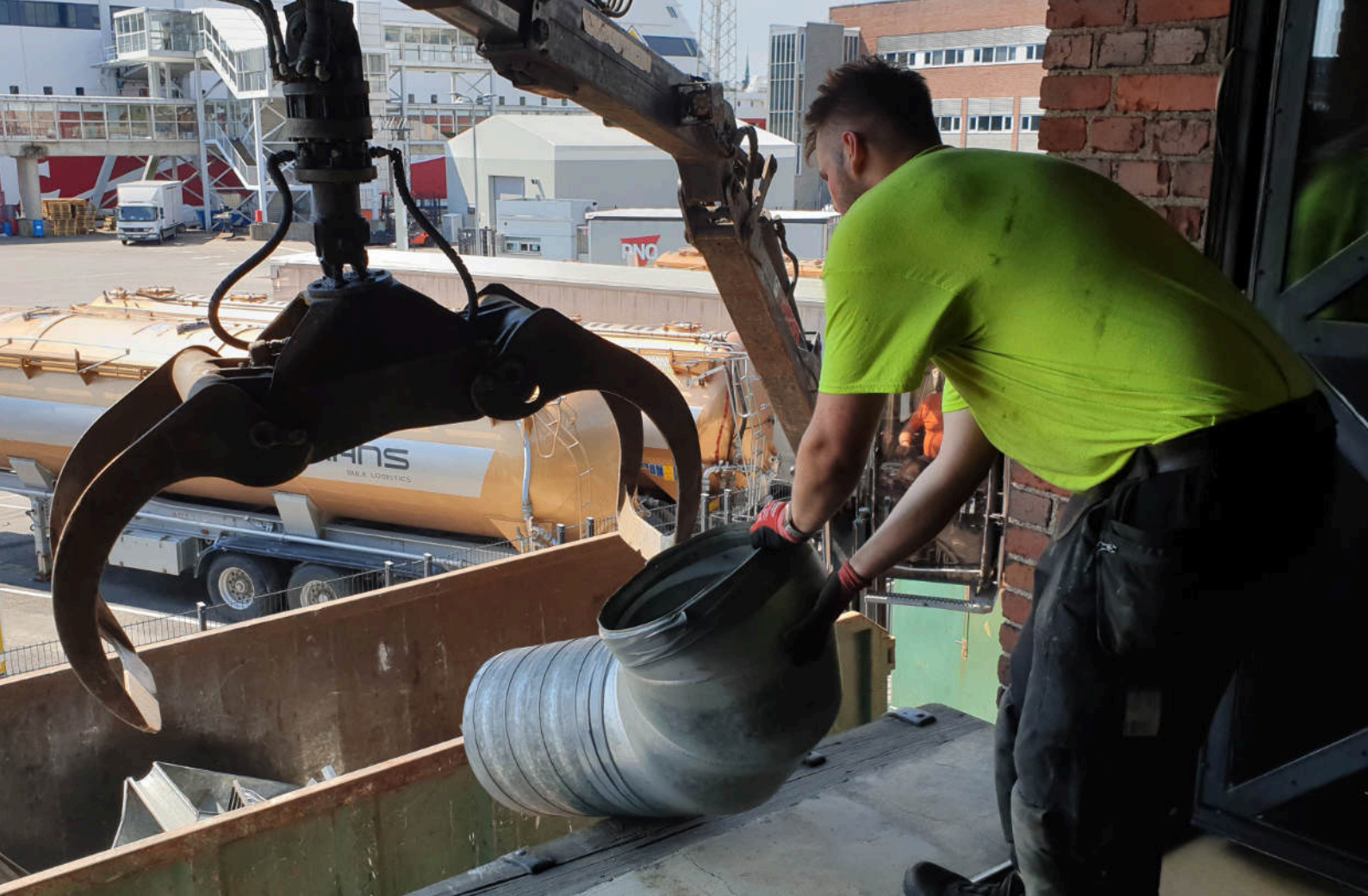
Elokuvasäätien kiinteistön ilmanvaihto remontoitiin kesällä 2023.
